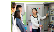
维电高级技师考核实训室
