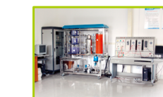
智能化高级过程控制实训室
