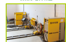
自动埋弧焊机实训室
