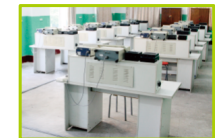
电工电子实训室
